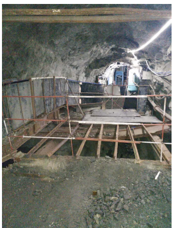
溜井防护设施
