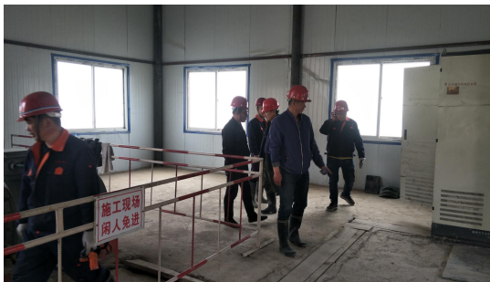
提升机房检查及防护设施
