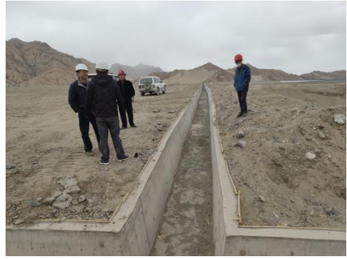
库区北侧排水明渠
