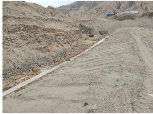
库区东侧坝体外坡及挡墙
