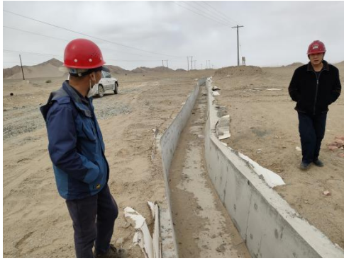
库区东侧排水明渠
