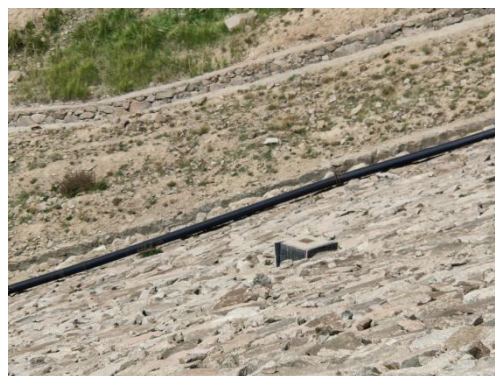
初期坝外坡面位移监测点及护坡
