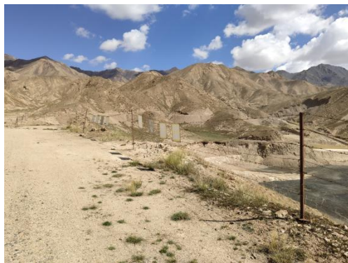
库区西侧上坝道路及围栏
