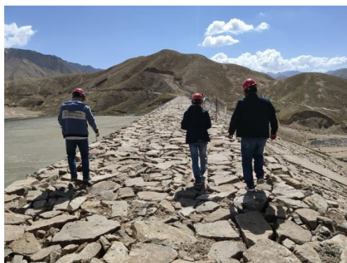
初期坝坝顶及防护围栏
