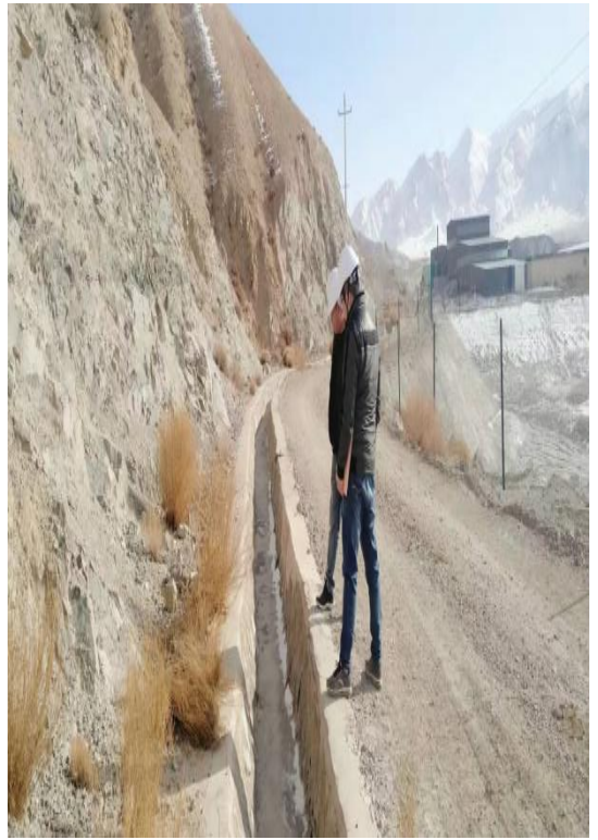
矿区东侧截洪沟
