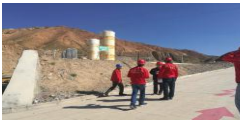
气化站西北侧气化装置区布置
