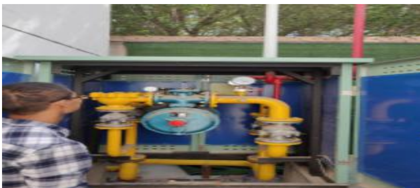
城镇输气管网集中供暖调压柜内部
