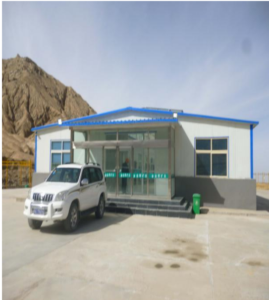
地面调度中心
