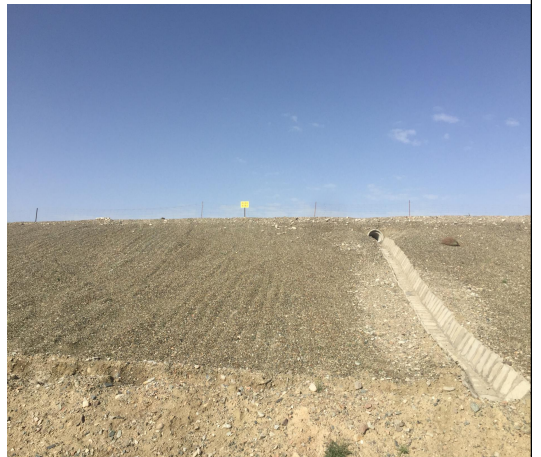
溢洪管及排水沟
