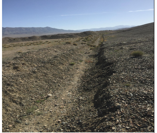
坝体底部截水沟
