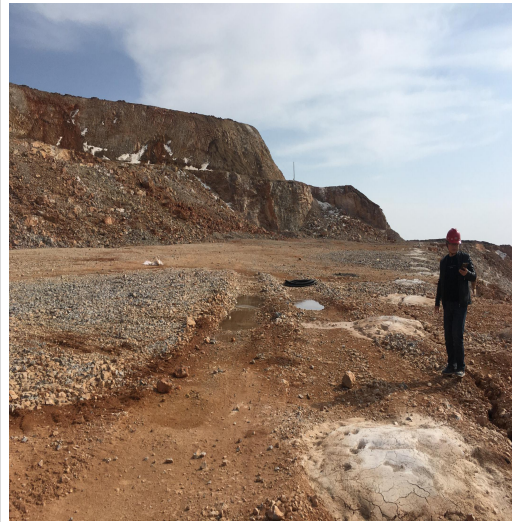
3220m 作业平台
