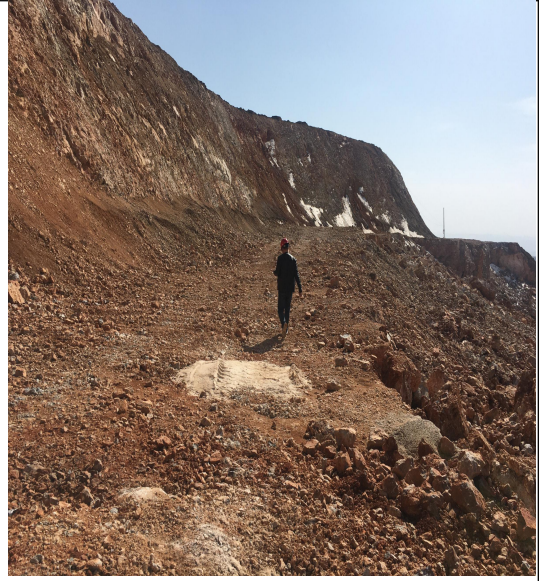
3235m 作业平台
