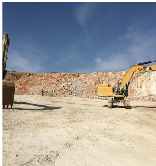
3190m 作业平台
