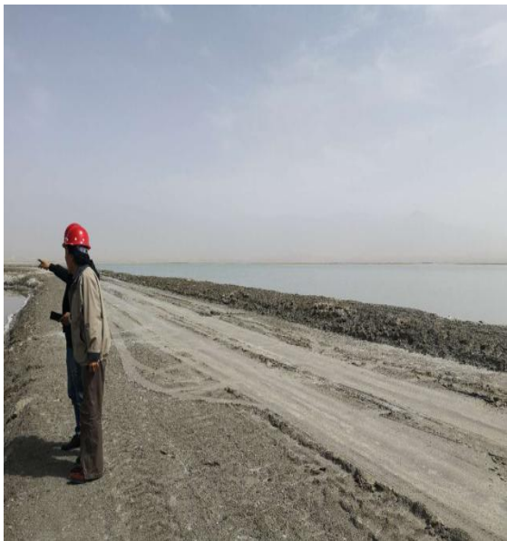
首采区围堰堤坝
