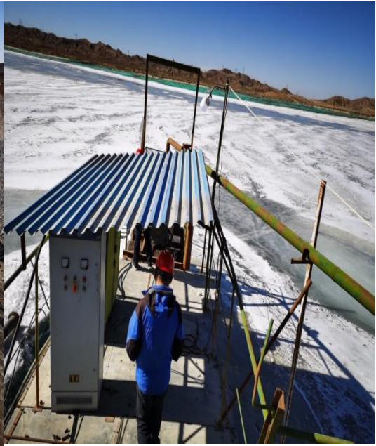
库内回水栈桥
