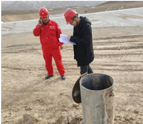
2#副坝下游扩散井
