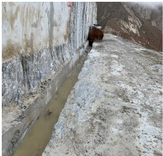
采场顶部截水沟
