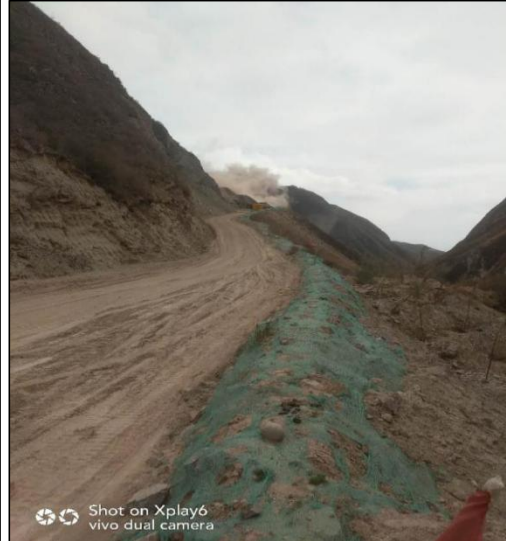
矿山道路及安全挡墙
