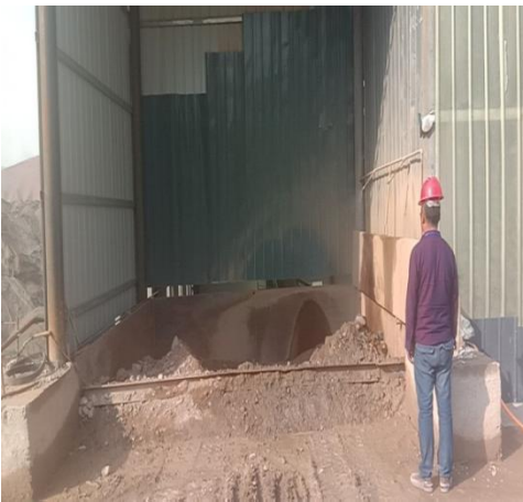
破碎站入料口
