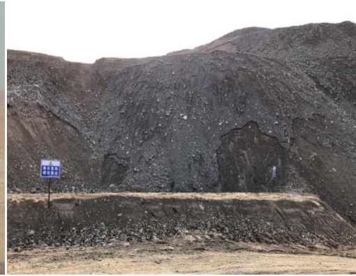
溜槽底部挡土坝
