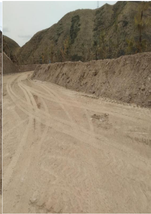
装矿平台挡石墙
