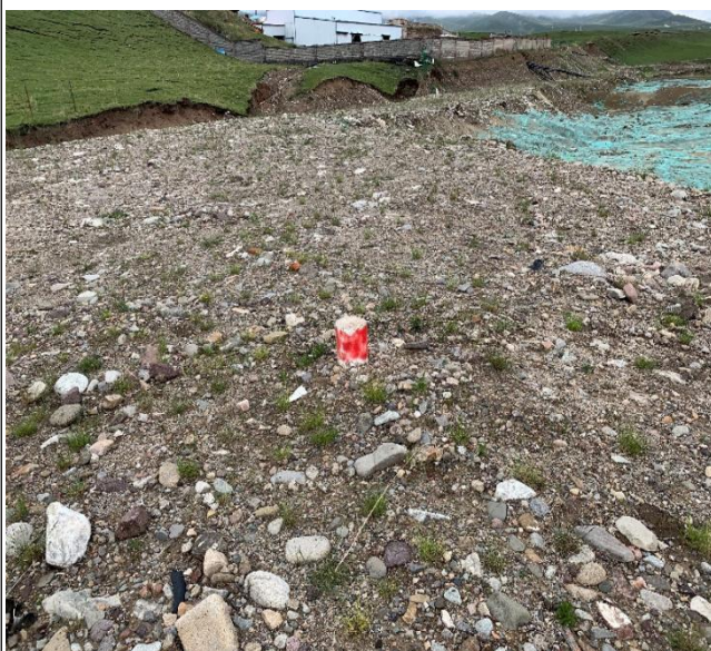
坝体位移观测点
