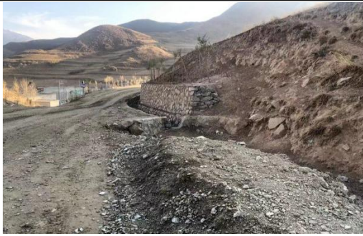
内部道路及排水沟
