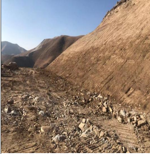
矿山基建平台边坡
