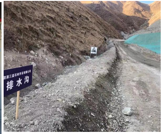
内部道路及排水沟警示标志
