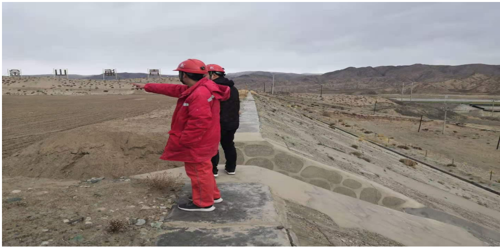
库内排水沟和坝体护堤
