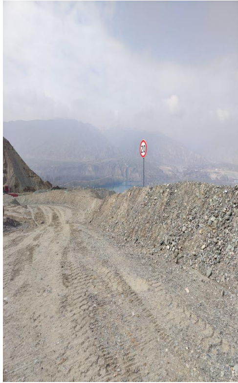
矿山道路及挡车墙
