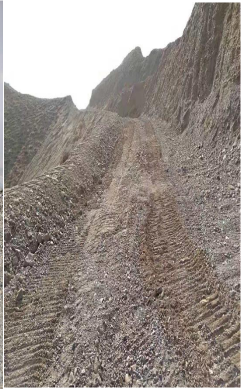
简易道路及挡车墙
