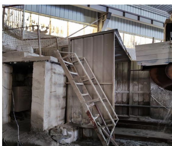
斜梯及防护栏杆
