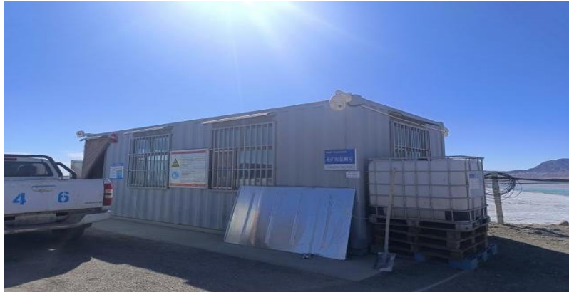
尾矿库管理站
