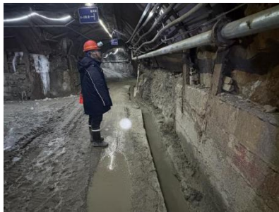
3150m 中段排水沟
