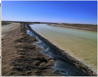
输卤渠防渗措施
